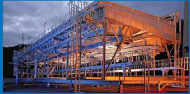
Fin Fan Repair
