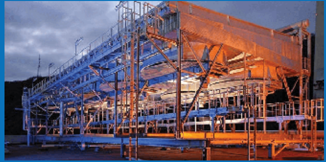
Fin Fan Repair
